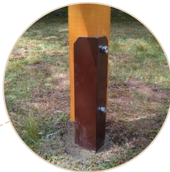
Ukázka ukotvení na ocelové L kotvy.
